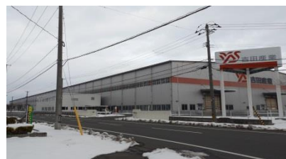
鋼材一次加工工場外観
